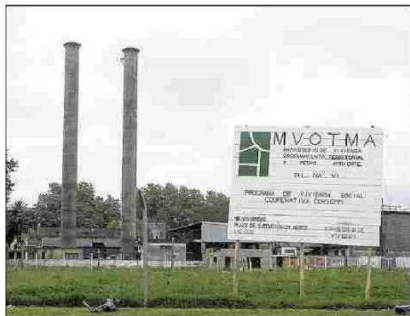
Chimeneas. Junto a ellas se están construyendo viviendas.
